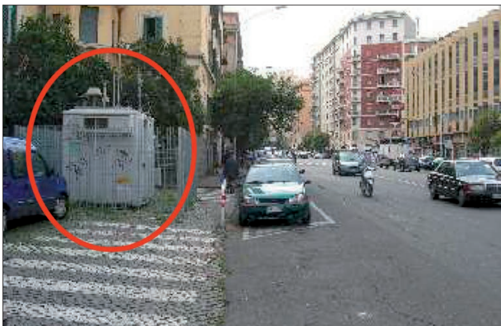
Fig. 2 - Esterno e interno della stazione di rilevamento tipo
