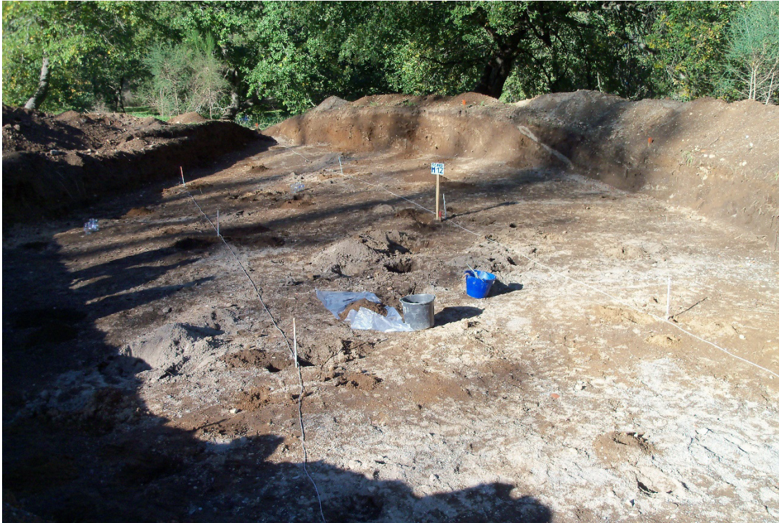
Figure 2 – Suddivisione in campo del fondo scavo di M12 ( A = \text{ca } 185 \text{ m}^2 ) in tre sub-porzioni di fondo/parete per la formazione di tre campioni compositi (C-M12-A, C-M12-B e C-M12-C)
