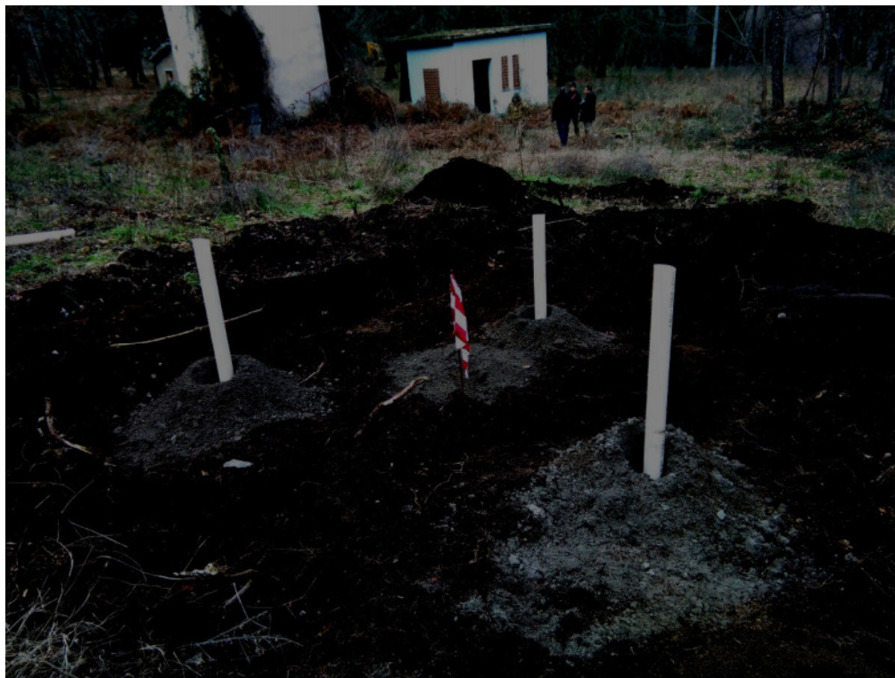
Figure 8 - Dettaglio piazzola per piezometro dopo messa in sicurezza
